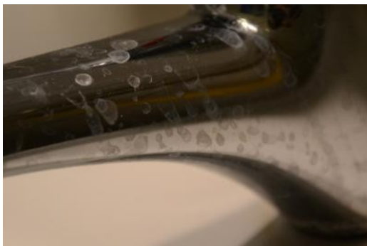
Vodní kámen na vodovodní baterii
